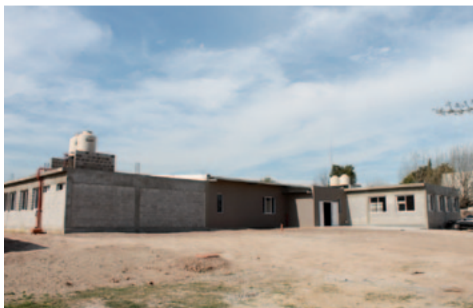
Instalaciones del Instituto terciario Fátima.
